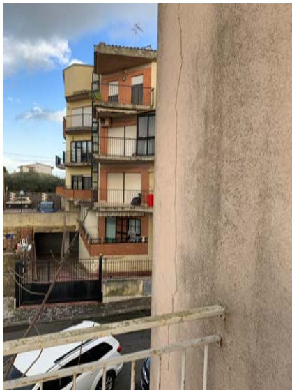
Figura 16 – Particolare della facciata esterna con ammaloramenti
