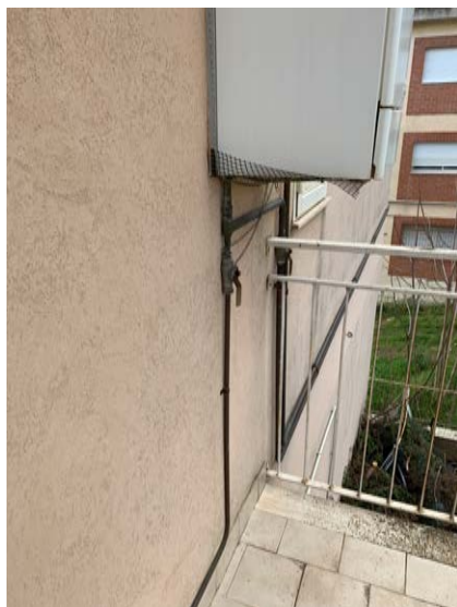
Figura 11 – Caldaia murale a metano sul ballatoio laterale
