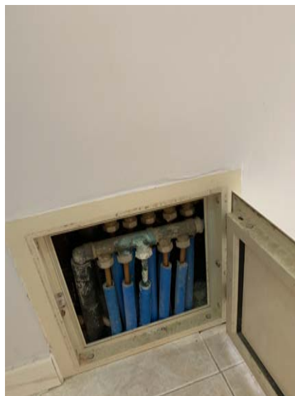
Figura 12 – Collettore impianto di riscaldamento
