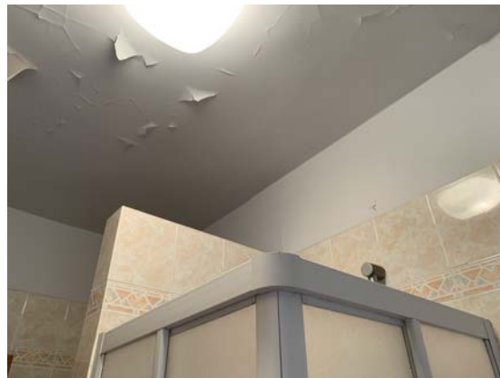
Figura 17 – Soffitto del wc con segni di pittura scarpolata segno di probabile umidità
